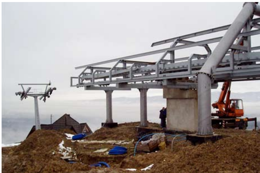
Wyciąg - plac budowy po postawieniu słupów kolejki
